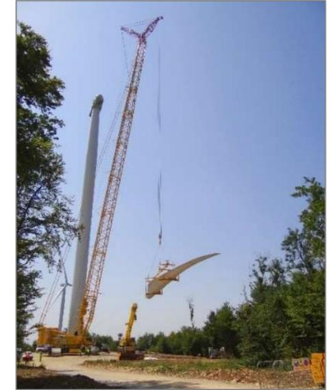
La nacelle est positionnée en haut du mât, suivie par le moyeu et les pales.
